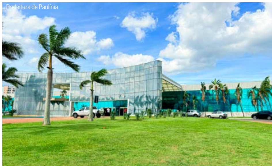
Fachada do Paço Municipal Prefeito José Lozano Araújo em Paulínia
